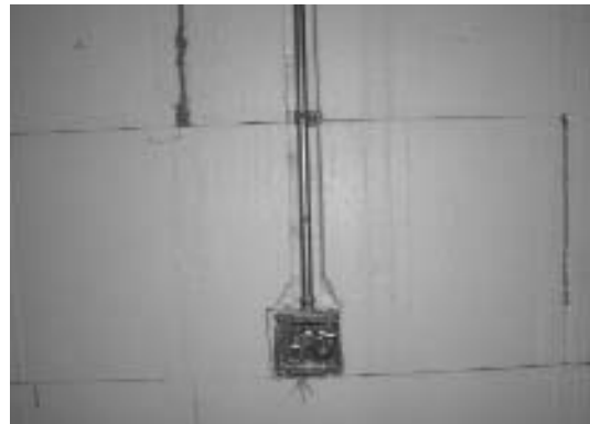
ELECTRICAL CONDUIT INSTALLATION
